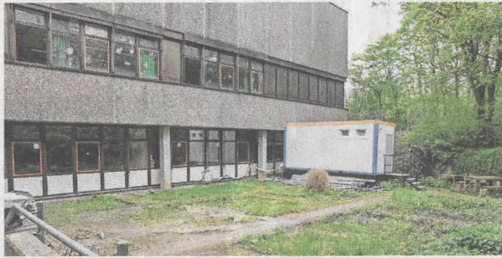
Ein Sanierungsfall: Ein Neubau der IGS ist laut Stadt nicht umzusetzen. Rot-Grün fordert jetzt, wenigstens einen Teilneubau zu prüfen. FOTO: KATRIN KUTTER
