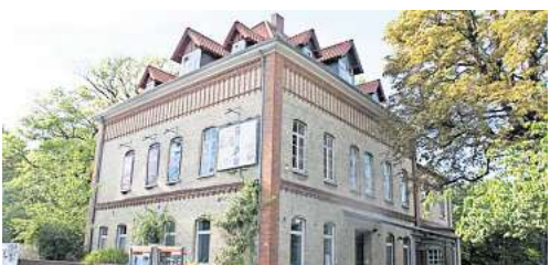
Gelber Klinkerbau mit orangefarbener Inneneinrichtung: Der denkmalgeschützte Jazzclub Hannover auf dem Lindener Berg. FOTO: ROBIN BECK
