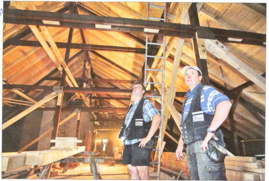
Die Handwerker Rolf Benecke und Volker Mill haben im Dachstuhl der Schule noch so einiges vor sich.
