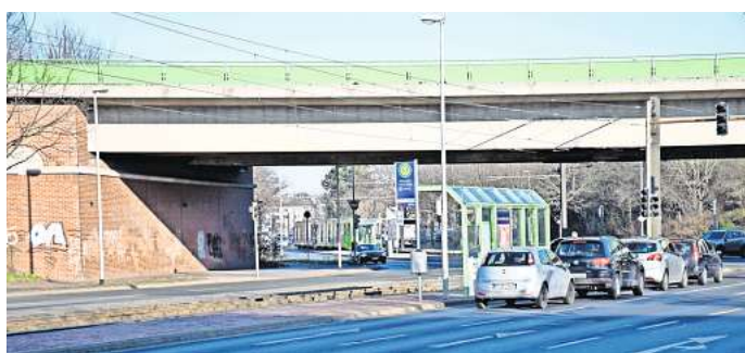
Auf der südlichen Seite der Bundesstraßenbrücke befürchten die Ronnenberger unzumutbare Verkehrsbelastungen. FOTO: KRANZ
