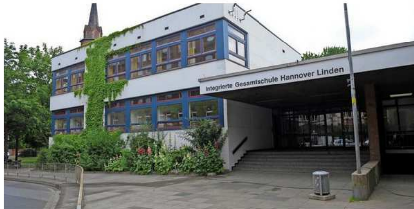
Schulsanierung in den Sommerferien IGS Linden. Jetzt fordert der SPD-Ortsverein Linden-Limmer einen Neubau. Quelle: Nico Herzog
