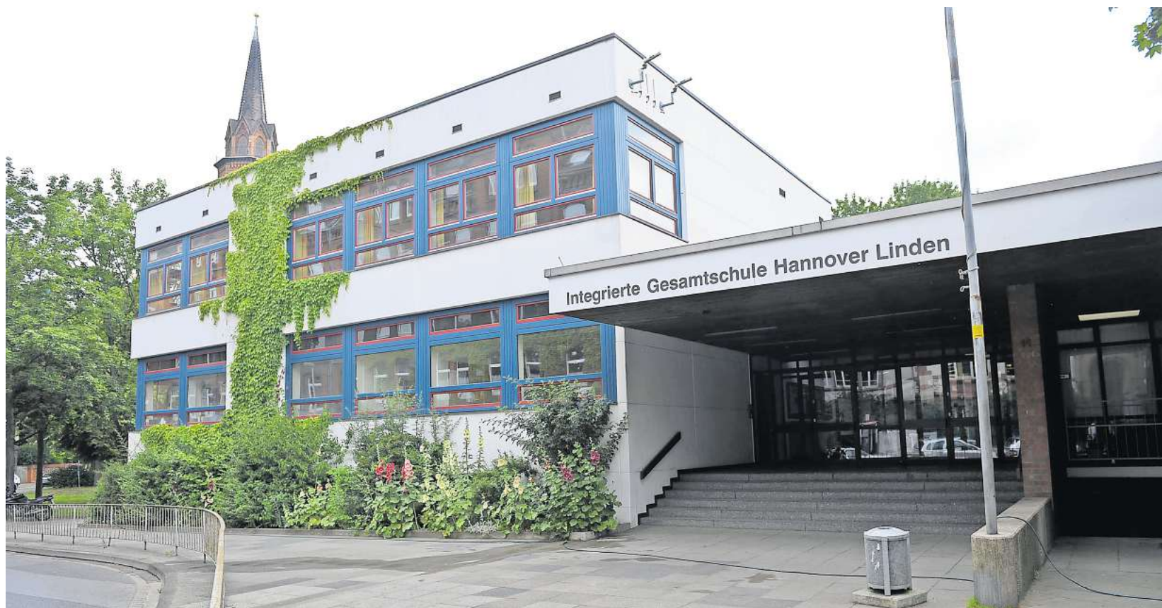
In die Jahre gekommen: Das Hauptgebäude der IGS Linden weist zahlreiche Mängel auf.
