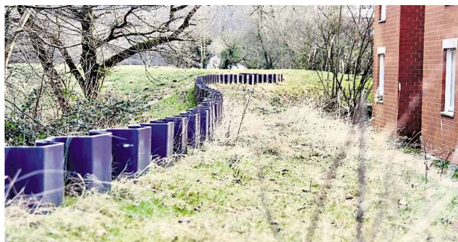
Schon fertig: Der neu aufgeschüttete Deich am Studentenwohnheim Am Papehof.
