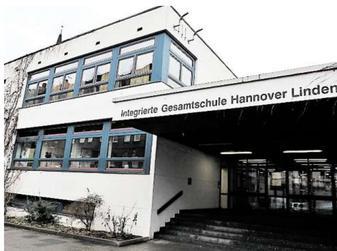
Sanierungsbedürftig und zu klein: Das Hauptgebäude der IGS Linden. FOTO: BEHRENS
