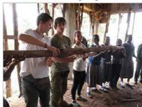
Gemeinsame Arbeiten am Bau
