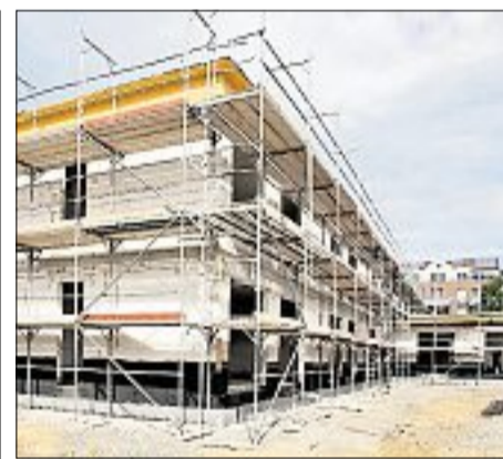
Der Rohbau steht: Die neue Kita in Vahrenwald.
